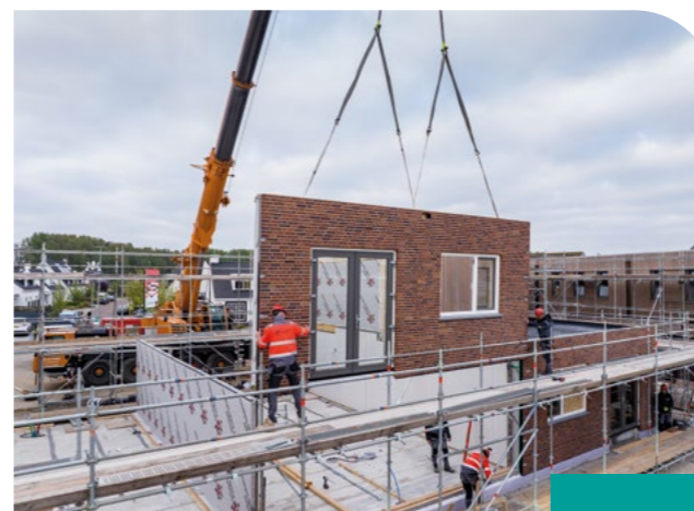
Op locatie worden de prefab onderdelen in elkaar gezet.
